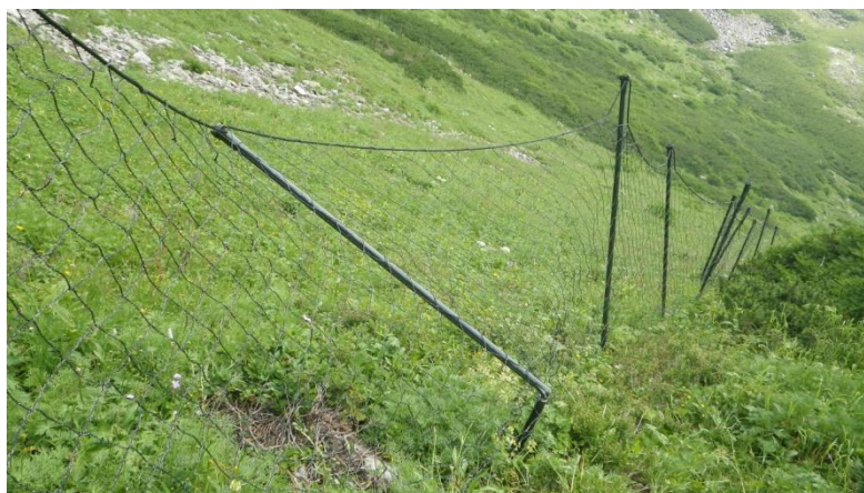
写真 4.3.1 防鹿柵 A における折損の状況
