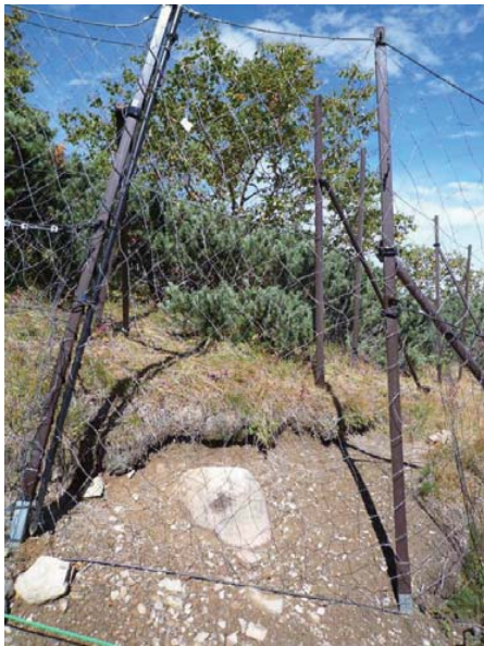
図IV-1-15 柵5の出入口(カーテンゲート) 閉めた状態
