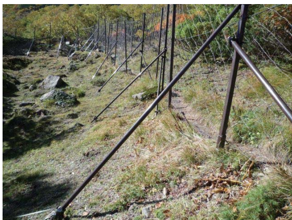
図IV-1-11 柵1の支え支柱の様子(柵の内側)
