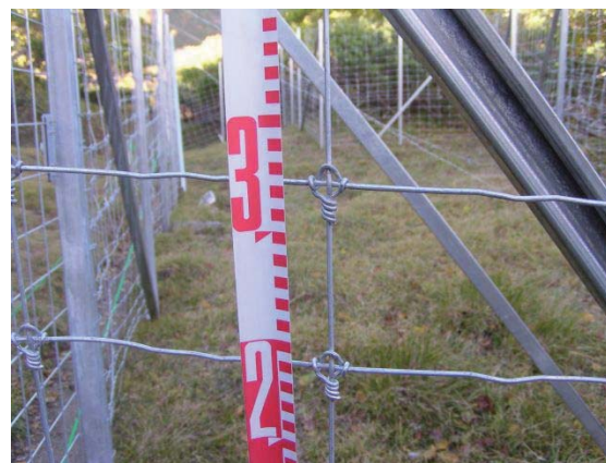
図IV-1-18 金網の様子 金網は2枚が継ぎ足されて設置され、 支柱の数カ所で金具で留められている
