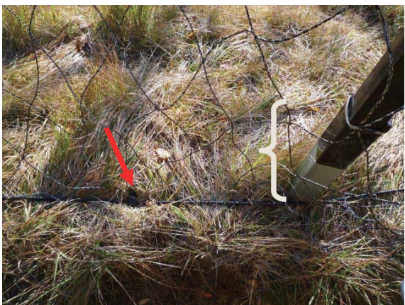
図IV-1-10 ネット下部の状態 ワイヤーが通され、フックで地面に留められている(赤矢印) 下部支柱(直径6cm)が地中に約60~80cm埋め込まれ、そこに上部の支柱が差し込まれている(白カッコ)
