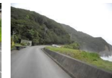
歩道の状況 (二ツ浜)
