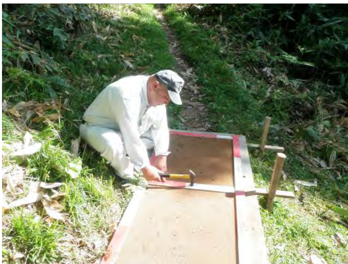
美濃禪定道 マットの設置作業
