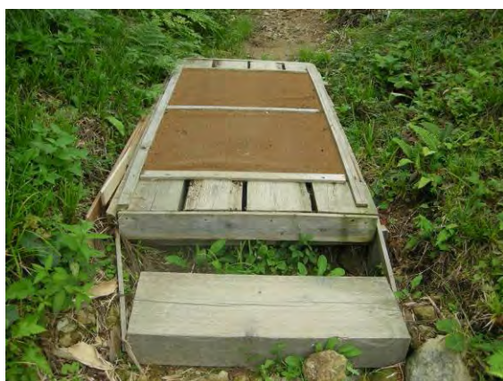
設置後の様子
