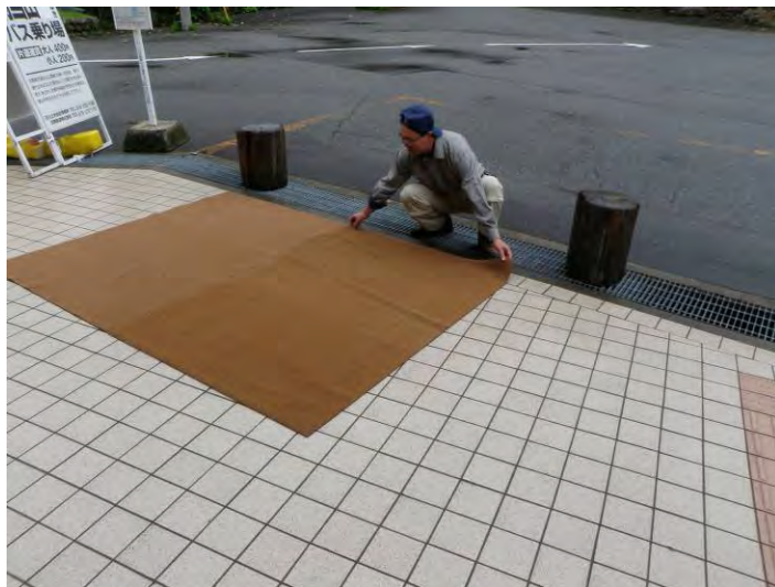
市ノ瀬 マット設置作業
