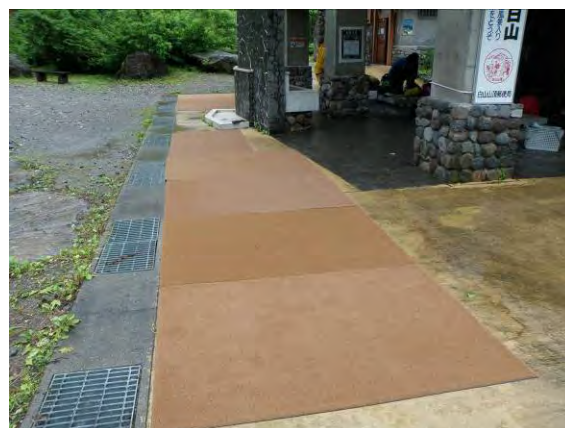
マット設置後の様子
