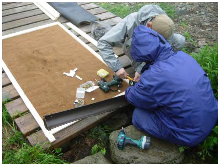
南竜（展望歩道） マットの設置作業
