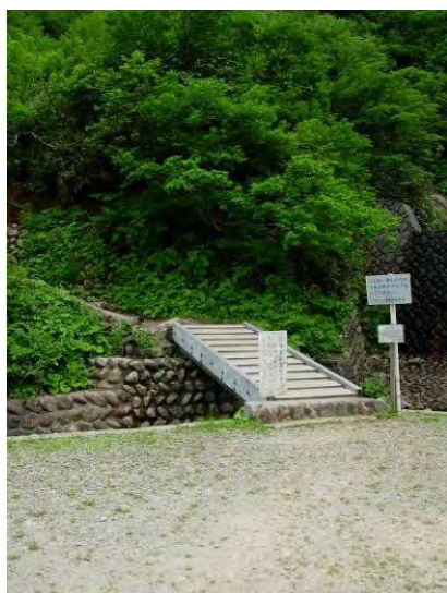
設置した砂利スペース
