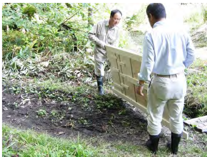
刈込池登山口 マットの設置作業
