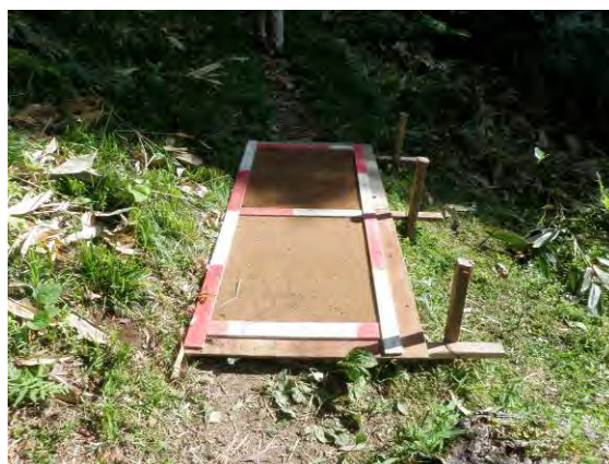
設置後の様子
