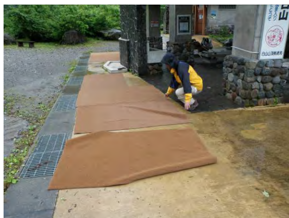
マット設置の様子
