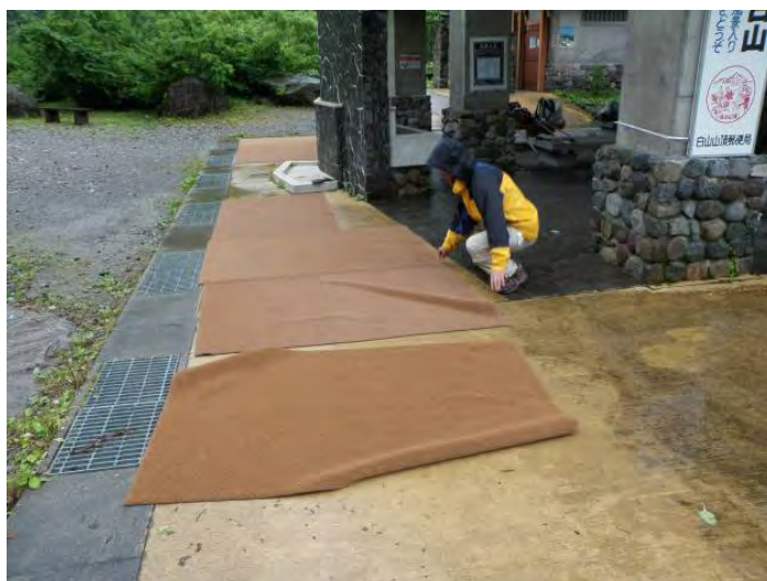
別当出合 マット設置作業
