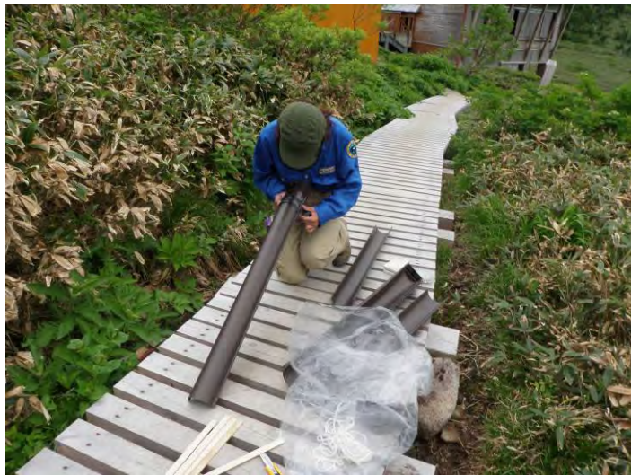
南竜（トンビ岩コース） マット設置作業
