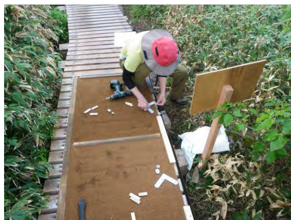
解放部のL字金具の設置
