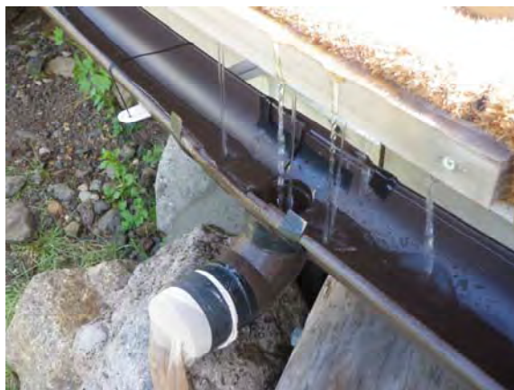
雨水による土砂流出対策
