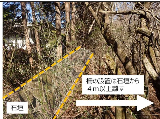
民地との境界に石垣（高さ1～1.5m）が続く。石垣で柵外が高くなっており、外からシカが跳躍して柵内に侵入してしまう。それを防ぐため石垣がある場所では石垣から4m以上離して柵を設置する。
