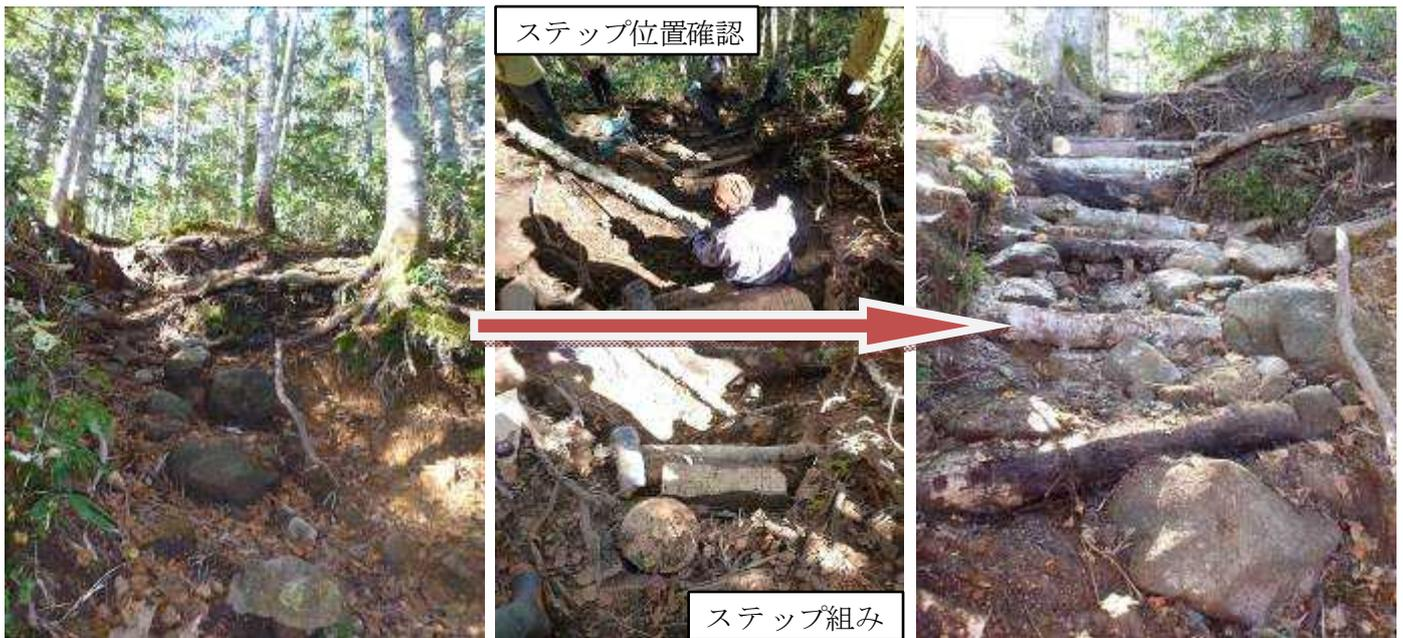
木の幹を用いた導流水制工完了
