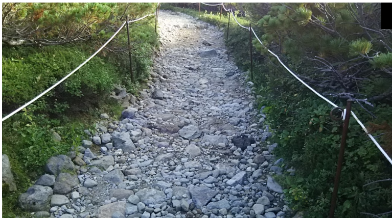
写真⑧ 床止工 施工1年後
