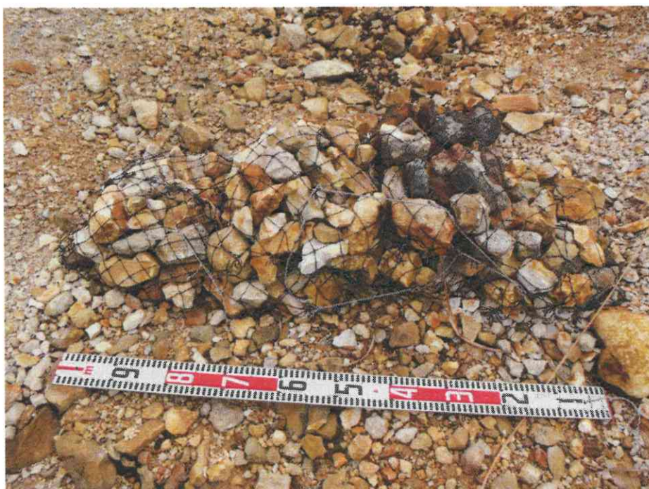
写真-② 2018.5.9 試験礁は網地の破損や変形、移動、滑落も無く、安定性は高いとみられる
