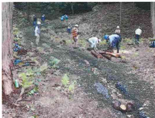
散策道にできたみず道の補修作業
