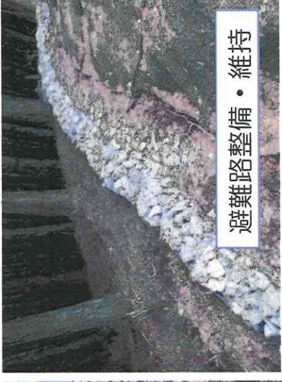
簡易石積み土留め対策
