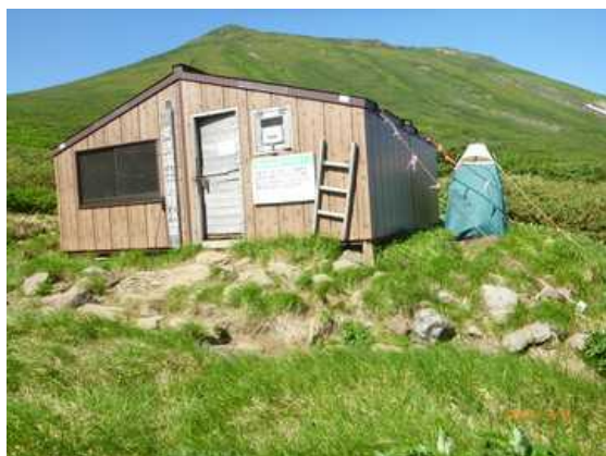
美瑛富士避難小屋の仮設携帯トイレブース
