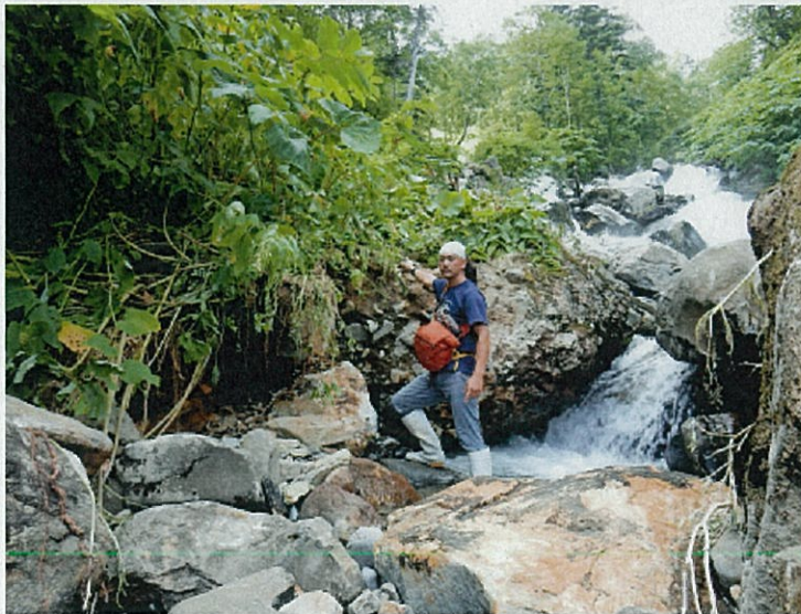
ヤンベの滝歩道も 170 cm 程崩壊し直下の歩道は歩行不可.
