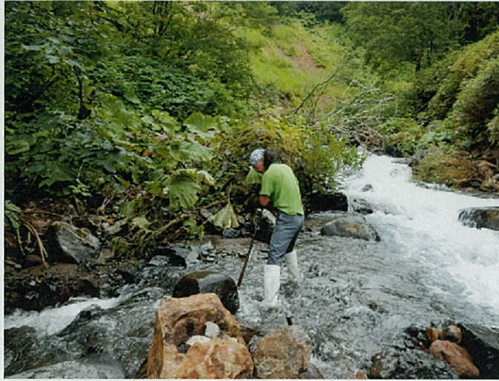
ヤンベタツプ沢の約 100m 上部で流れの切替作業.
