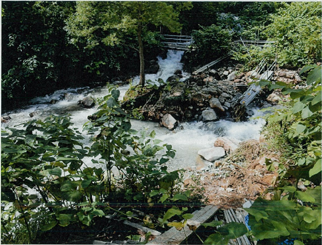
9月1日ヤンベタツ沢最初の橋は流失し2番目のは崩壊し歩行不可
