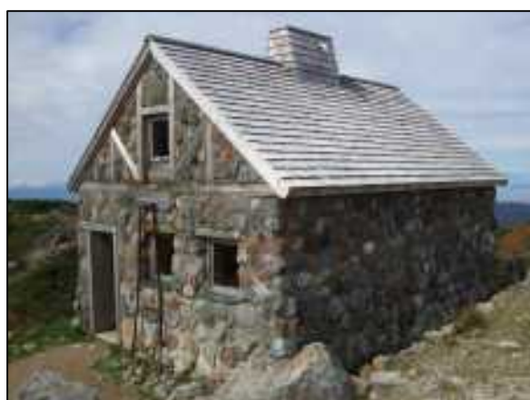
写真 2-5-3 旭岳石室外観
