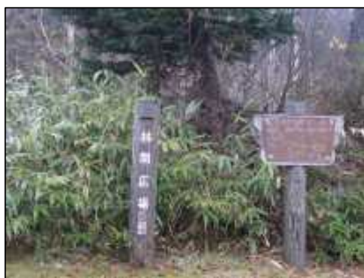
写真 2-5-1 勇駒別園地 老朽化した看板類
