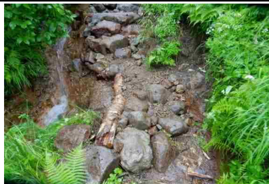
＜エゾ沼付近＞ 床固工
