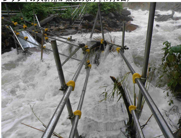
④ 「水の恐怖」梅雨前線が北海道に停滞し、7月2日からの大雨でヤンベタツ川が増水し、橋に水がかぶっています。7月6日に補修をし、コースを再開しました。ただ、少しの増水でも橋に水がかぶる状態です。(7月4日)
