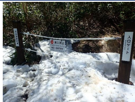
入口ゲートの取付け
