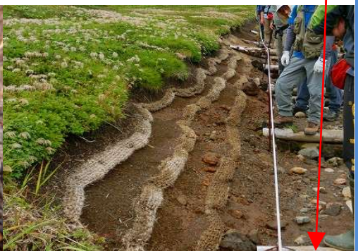
2016. 2017年に行なった侵食防止のヤシネット施工に植生復元を多々確認。2年目の植物もあり、凍上にも耐えたようだ。
