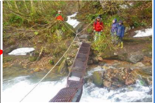
イズミノ沢に架かる橋 昨年からの曲がりが増している。 ロープ手すりを設置し、歩行は可能。
