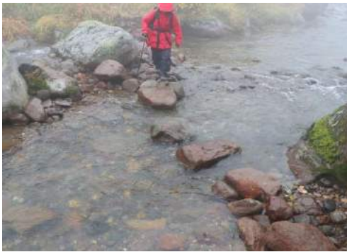
ピウケナイ沢の渡渉。 昨年までの飛び石が完全に流されていたが、 チェンブロックを使用し大きい石材を使って飛び石を施工。
