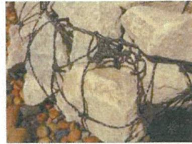
石詰め形成例 山道仕様は踏圧破損を防ぎ石材補充が容易です。
