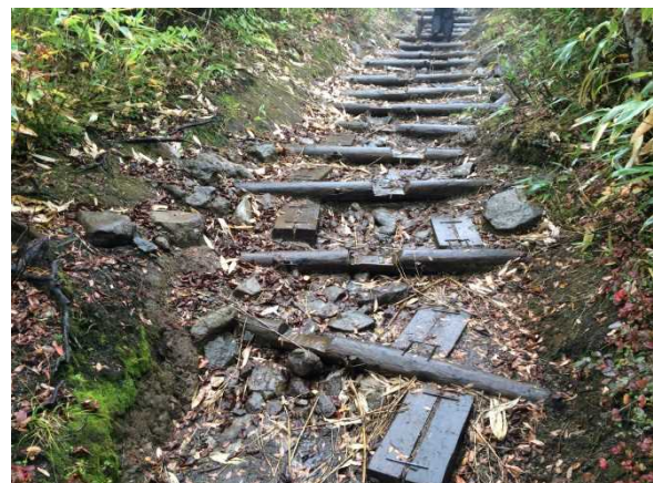
木柵ステップ&プール工
