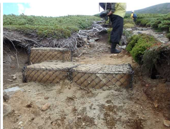
施工直後中岳温泉上部 (2014. 8. 29)
