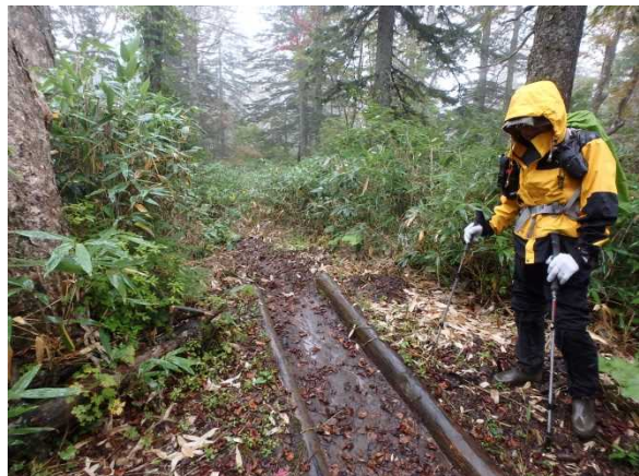
土砂除去を考慮し杭を溝内に打たない 短縮口分岐～カムイ天上間(2014. 9. 9)
