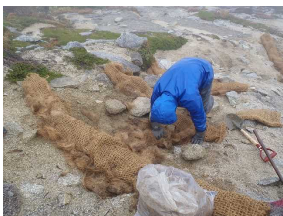
ガリーにも直接詰める
