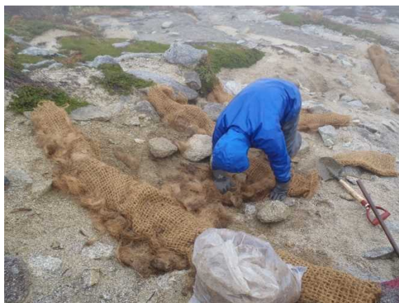
ガリーにも直接詰める
