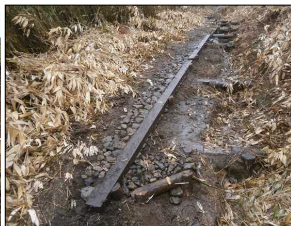
木柵土留工の路肩保護
