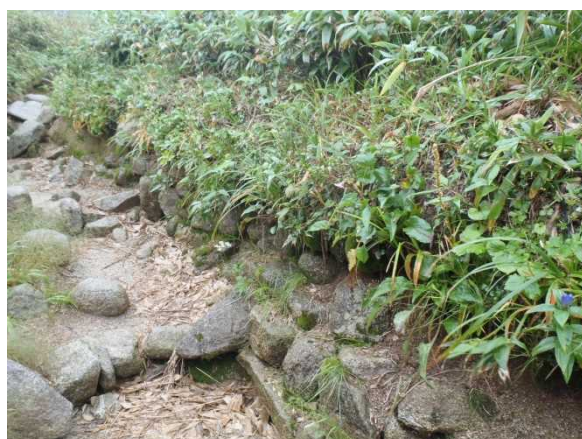
植生がオーバーハングしていた箇所の石積
