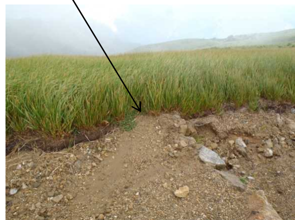
排水部の状況
