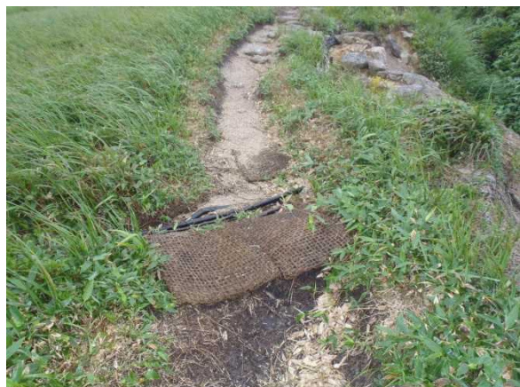
下流側をヤシ製土嚢で補強 (2014. 8. 15)
