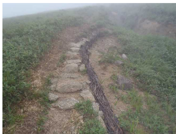
連柴（粗朶）による路肩補強
