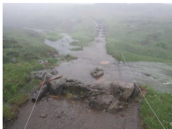
石で堰き止め登山道外に排水する
