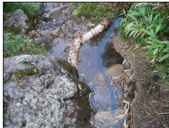
登山道内の流れを堰き止め谷側に排水する
