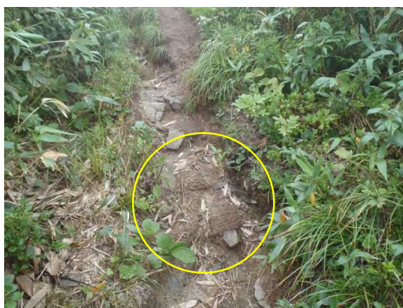
ステップとして設置されたヤシ製土嚢
