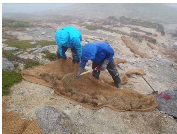
ヤシ製ネットにヤシ繊維と土砂を置く
