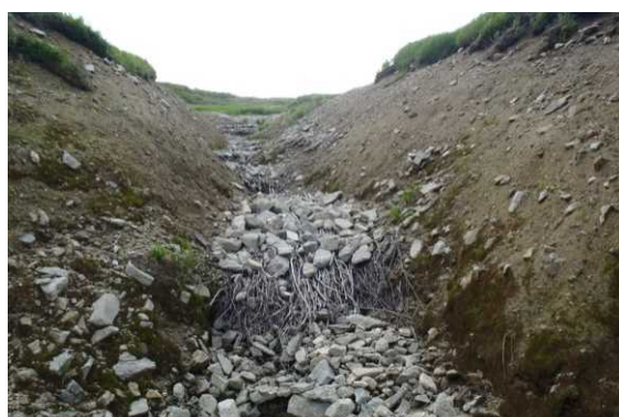
粗朶の上に石を載せる 施工2年後
