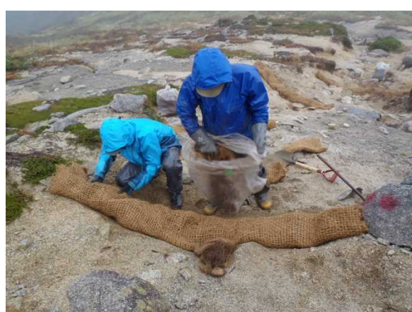
隙間にヤシ繊維を詰める
