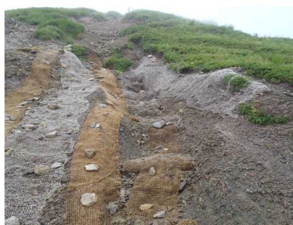
ヤシ製土嚢の土留+植生ネット 飯豊連峰(2014. 8. 21)
