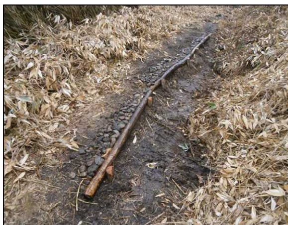
丸太による路肩補強
