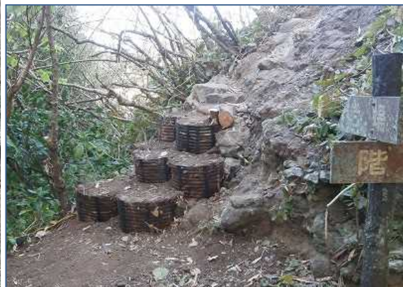
土留とステップを兼ねて設置
