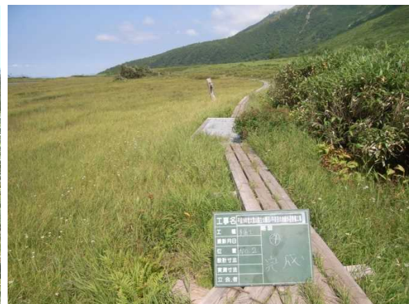
木道の床板に隙間を空ける 沼ノ平
