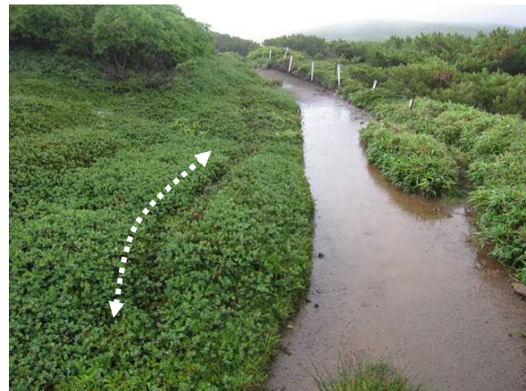
ぬかるみを避け植生上を歩いた痕跡あり 導水処理とともにロープ柵の設置が必要 雲の平 (2015. 8) 大雪山グレード3
