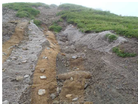
ヤシ製土嚢の土留+植生ネット 飯豊連峰(2014. 8. 21)
