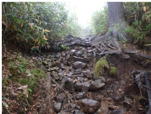
土留めの石組が崩れ歩きにくい
