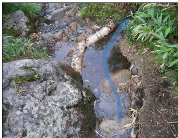
登山道内の流れを堰き止め谷側に排水する
