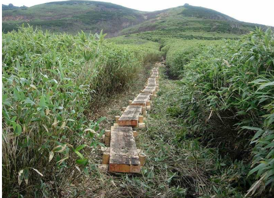
愛山溪 2005. 10月施工
