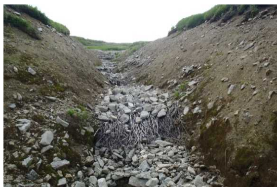
粗朶の上に石を載せる 施工2年後
