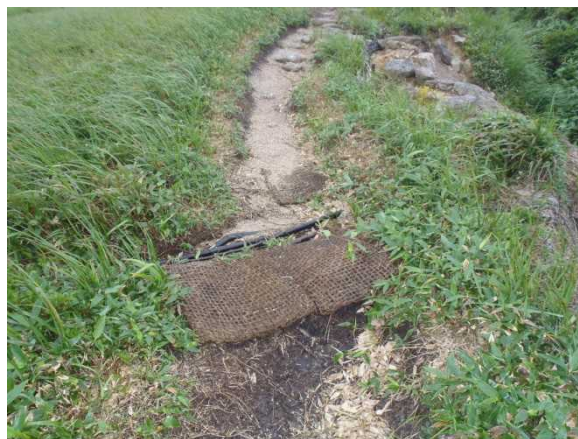
下流側をヤシ製土嚢で補強(2014.8.15)
