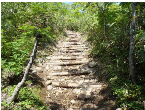
木柵により土砂が安定(2014.7.29)
