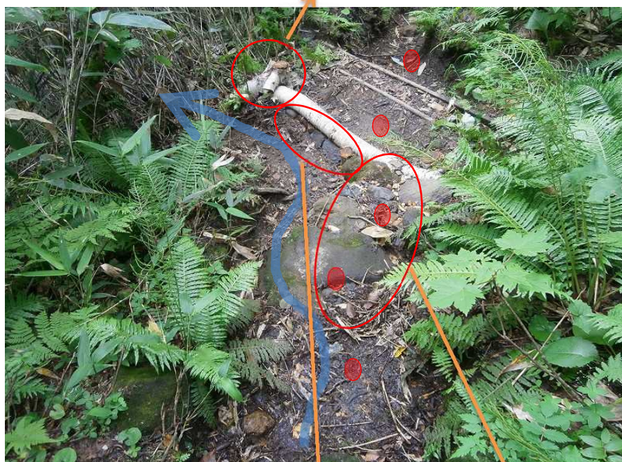
愛山溪・三十三曲 2013. 8月施工
