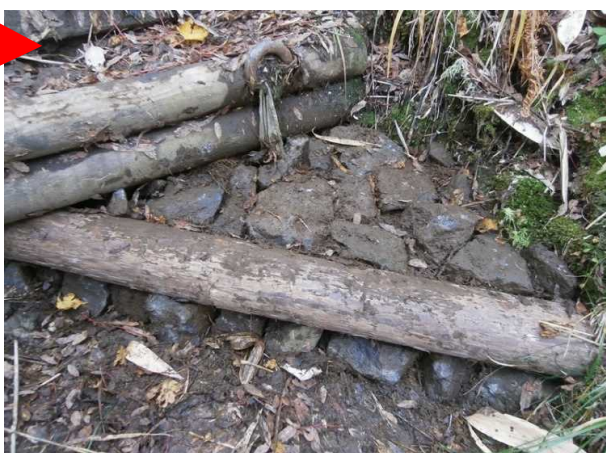
④石材敷詰め
