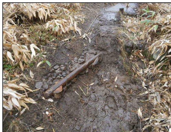
倒木と石でステップを設ける
