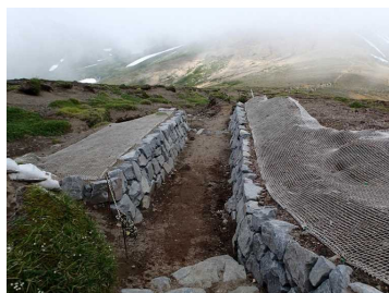
中岳分岐付近 2012年施工
