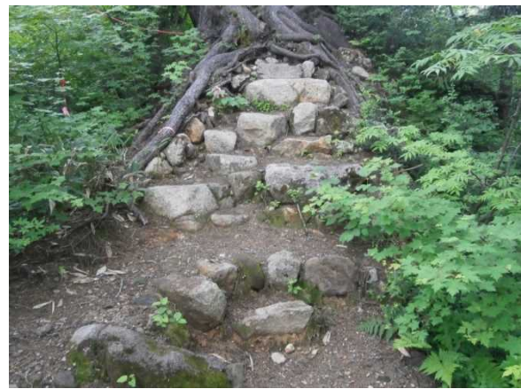
登山道修復技術研修で施工した石組
