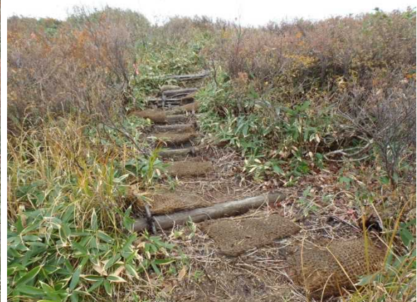
急勾配部には木柵土留を設置
