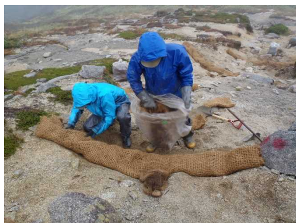
隙間にヤシ繊維を詰める
