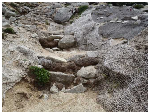
石組の上にヤシ土嚢を設置 朝日連峰 (2014.8.15)
