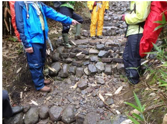
踏み石が小さく歩きにくい 土砂は安定
