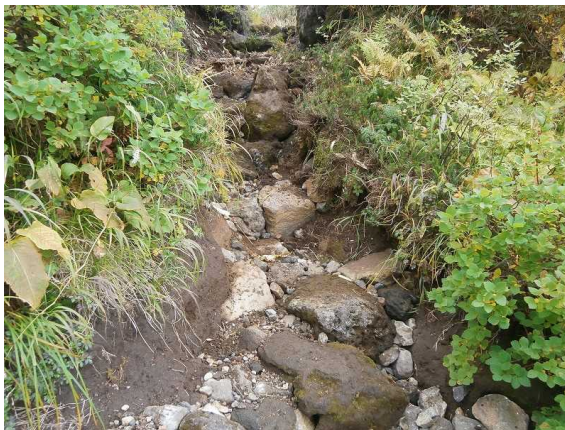
裾合平 2014. 9月施工
