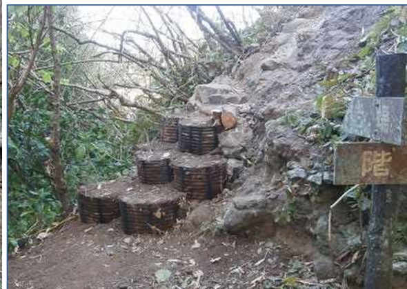
土留とステップを兼ねて設置
