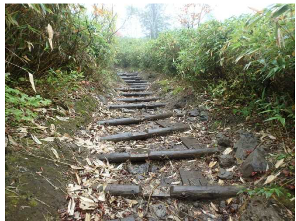
購入材によるステップ&プール工（木柵）
