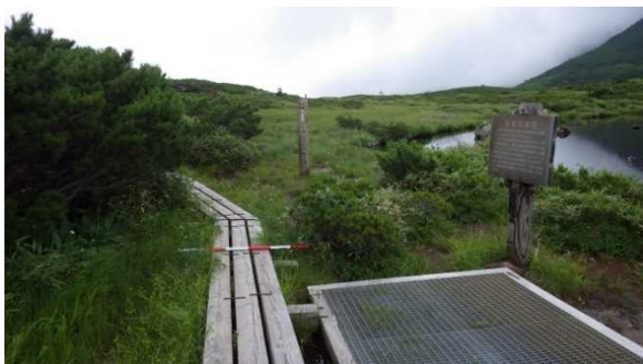
木道とデッキにより植生が回復（施工7年後）
