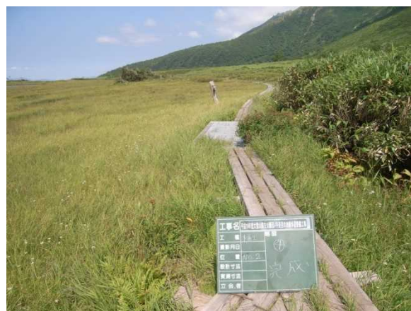
木道の床板に隙間を空ける 沼ノ平
