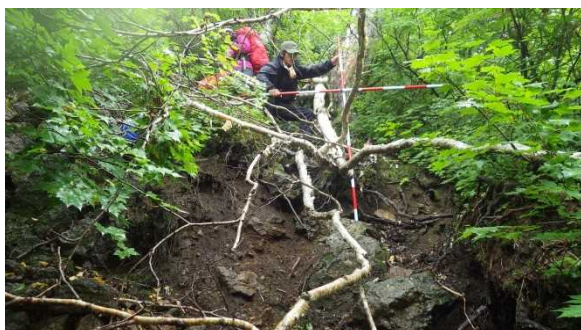
樹林帯の急勾配部でも著しく侵食が進行箇所 沼ノ原下部(2013.8.16)
