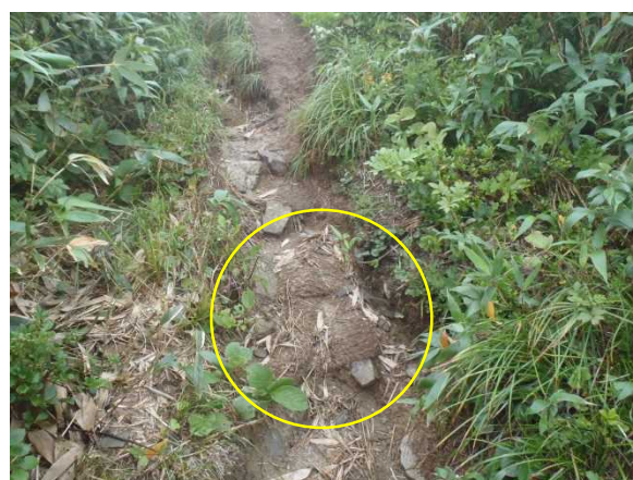
土砂詰まり固くなったヤシ製土嚢 水路化区間の床止工 段差が生じている ステップとして設置（施工2～3年後） 土嚢の追加設置が必要（施工2～3年後） 飯豊連峰(2014.8.21)
