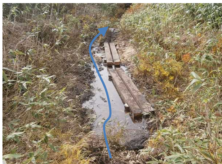
愛山溪 2014.9月施工
