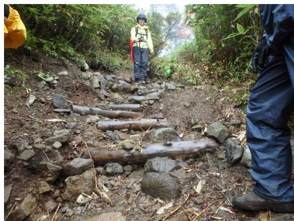
崩壊した石組を倒木で補修(2014.9.9)
