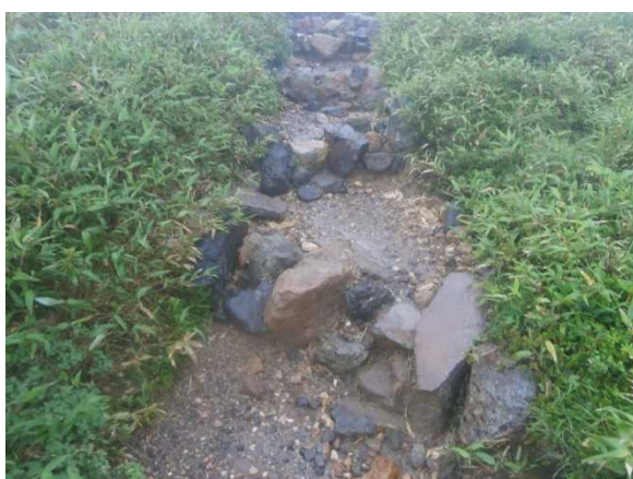
安定した石組（水量が少ない区間）
