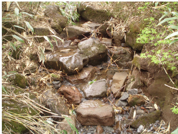
〔好例〕 現地資材を活かし自然な 石組がされた公共工事の例 愛山溪 (2010 年施工)
