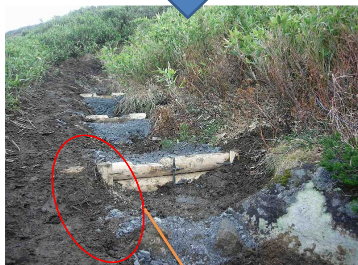
愛山溪・六の沼 2005. 9月施工
