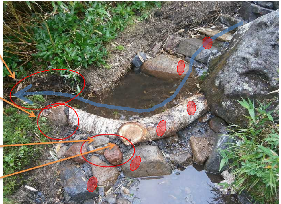
愛山溪・三十三曲 2013. 8月施工
