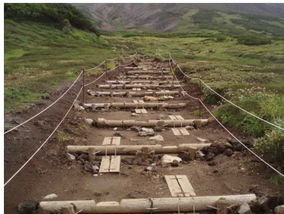
施工後 (2007 年度施工)
