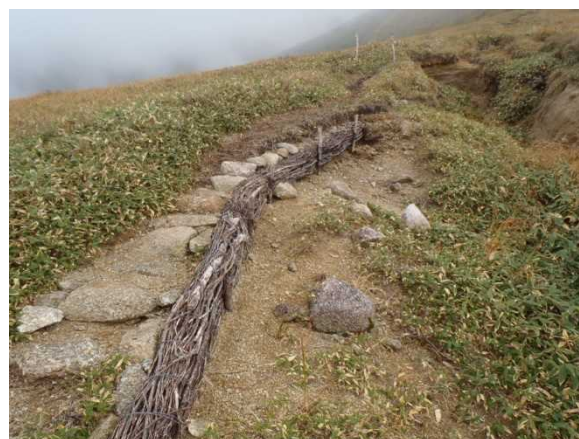
路肩保護として設置
