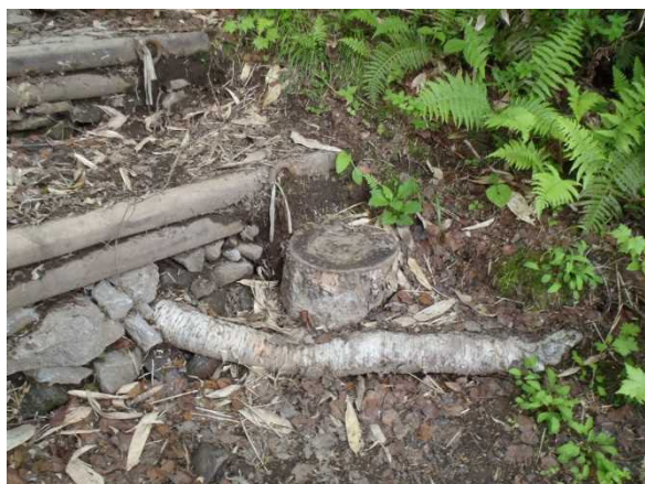
倒木を利用したステップ 三十三曲分岐～沼の平分岐間(2014.7.8)
