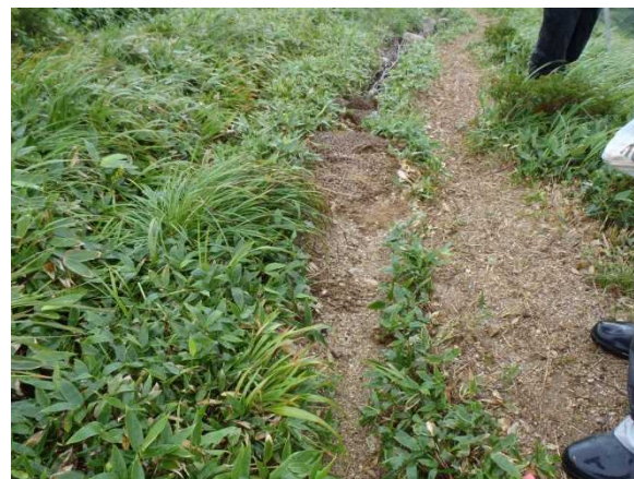
ヤシ土嚢を踏み面に置きぬかるみ化を防ぐ ヤシ土嚢の背後に土砂が溜り歩行部が安定 朝日連峰 以東岳直登コース
