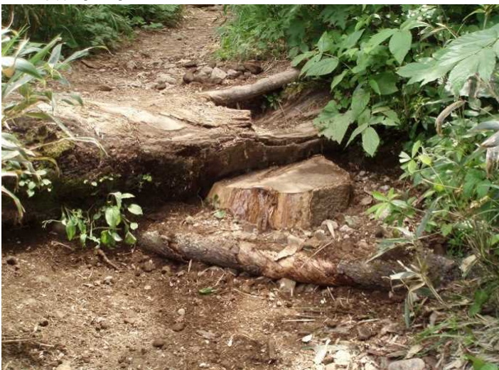
利尻山 2011. 7月施工
