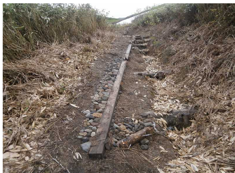
愛山溪 2006年施工(床止工) 2013. 10月補修(路肩保護工)
