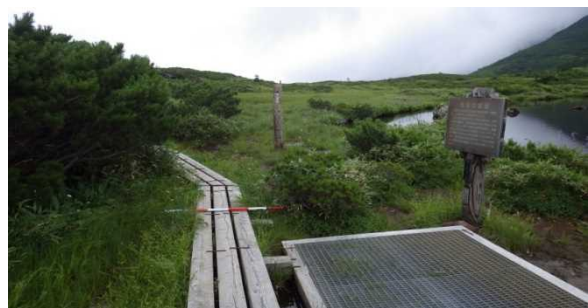
施工7年後 植生が回復(2013.8.21)
