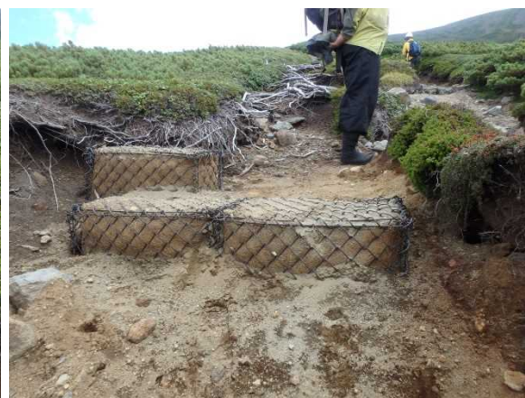
施工直後中岳温泉上部 (2014.8.29)
