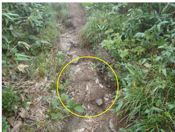
土砂詰まり固くなったヤシ製土嚢 ステップとして設置 (施工2～3年後)
