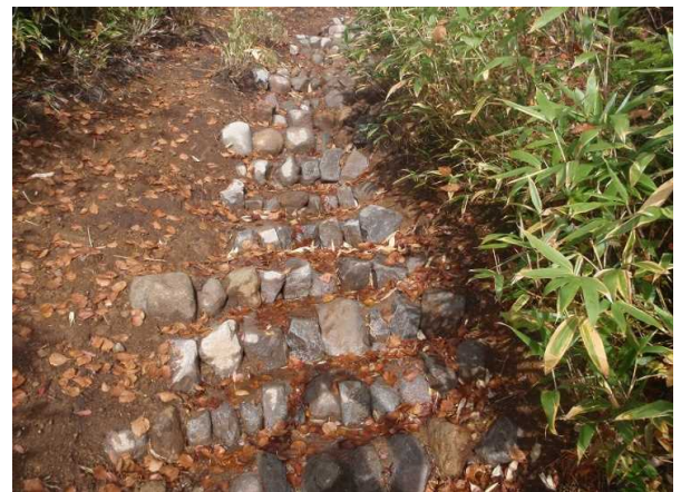
トムラウシ 2008年頃施工
