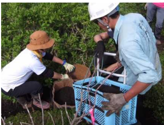
〔好例〕 テンサー工は軽い資材で施工性もよくボランティア作業も可 美瑛岳(2015.8)
