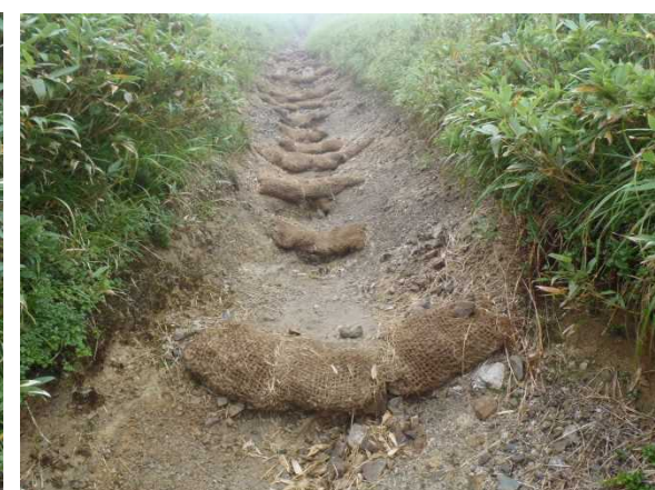
土砂詰まり固くなったヤシ製土嚢 水路化区間の床止工 段差が生じている ステップとして設置（施工2～3年後） 土嚢の追加設置が必要（施工2～3年後） 飯豊連峰(2014.8.21)
