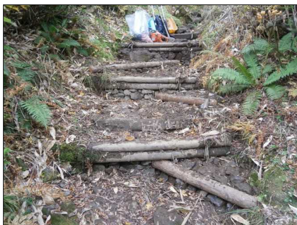
段差が大きい既設木柵工にステップを設置 三十三曲分岐付近
