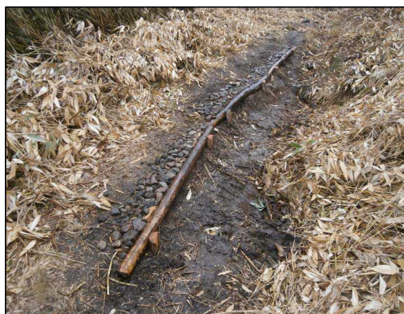
路肩を補強し歩行路を確保
