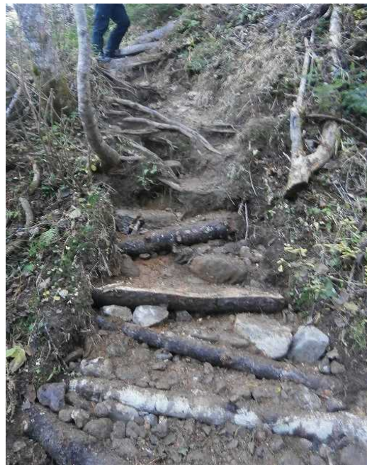
ニベソツ山 2013.10月施工
