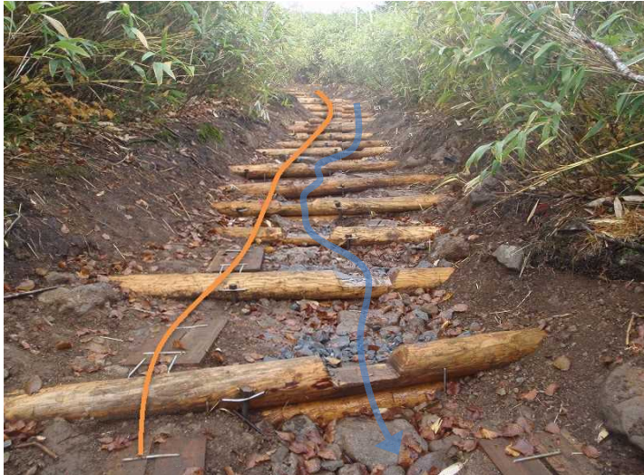
トムラウシ 2008年頃施工
