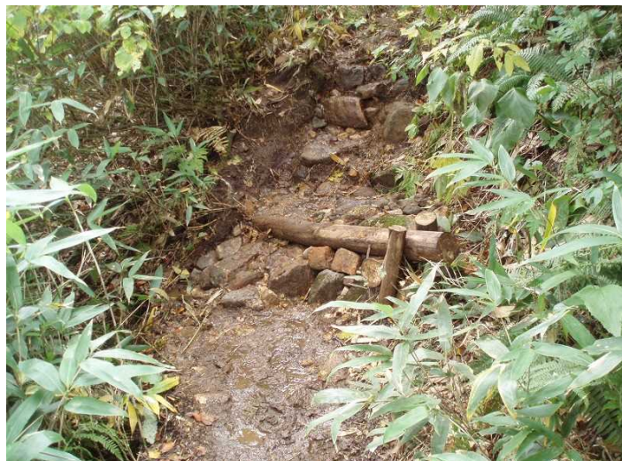
愛山溪・三十三曲 2007. 9月施工
