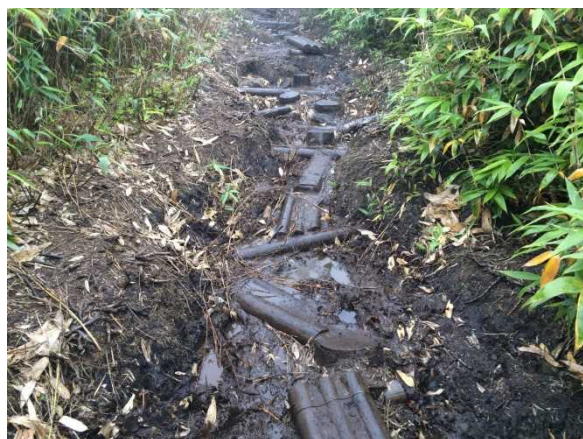
侵食底部のむかるみに設置された飛木道（初期）
