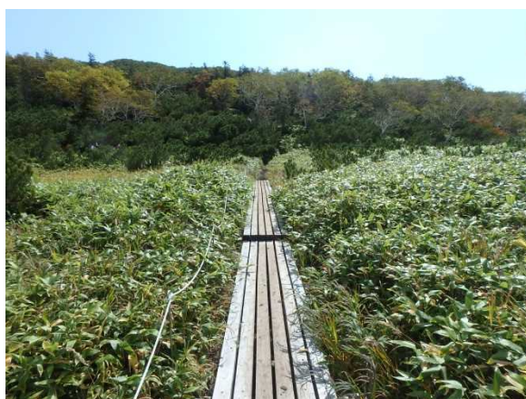
人力で運搬できる細い角材を利用 羅臼湖 アヤメが原
