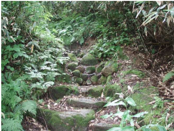
〔好例〕 多様な大きさの素材を 場所に応じ配置した例 三十三曲分岐付近(2008.8)
