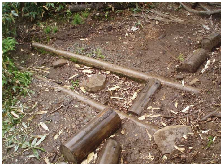
トムラウシ 2007年頃施工
