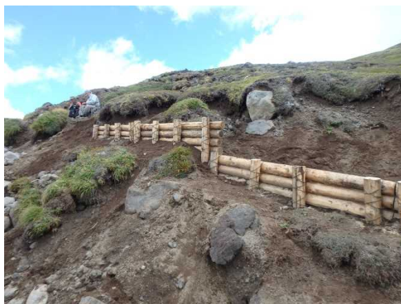
木柵土留工 中岳分岐付近(2014.8.29)
