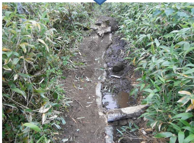
ニベソツ山 2014. 8月施工
