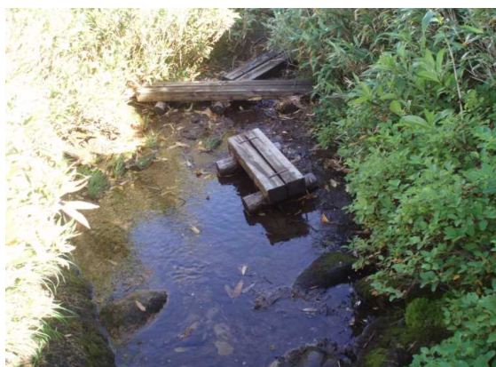
愛山溪 2006施工 2007補修
