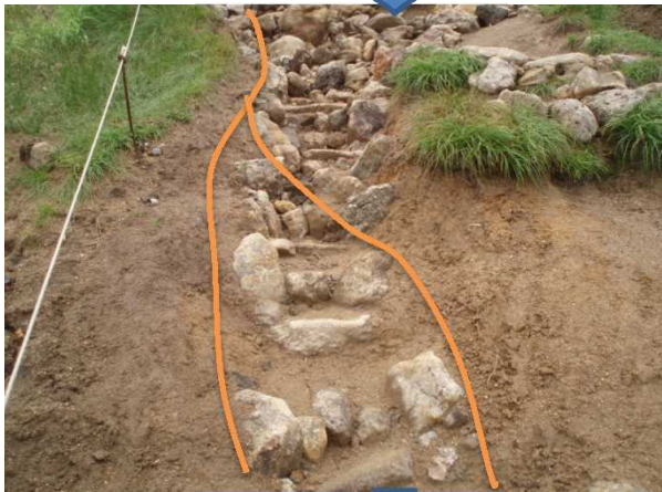
裾合平 2007.7月施工
