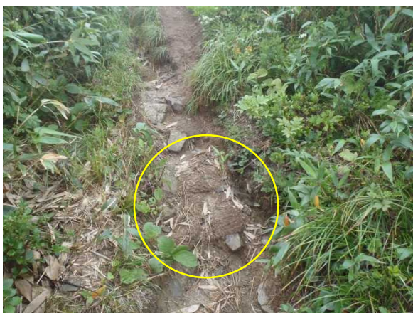
土砂が詰まったヤシ土嚢に植生が回復 飯豊連峰 (2014.8.21)
