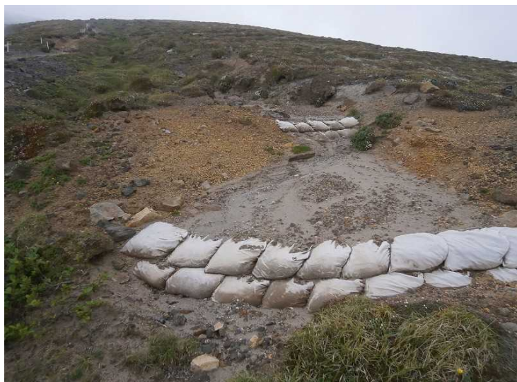
中岳分岐付近 2012. 8月施工 2014. 8月撮影
