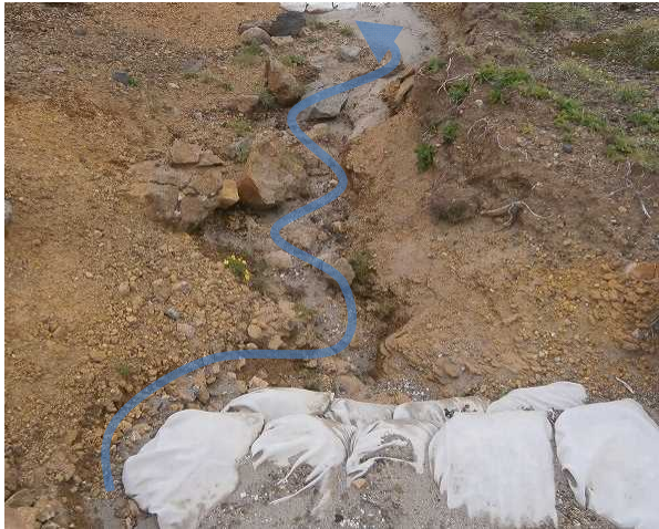
中岳分岐付近 2012. 8月施工 2014. 9月撮影
