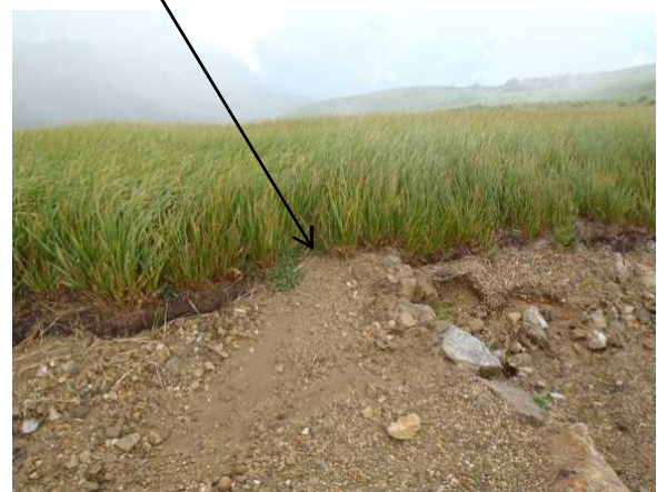
排水部の状況
