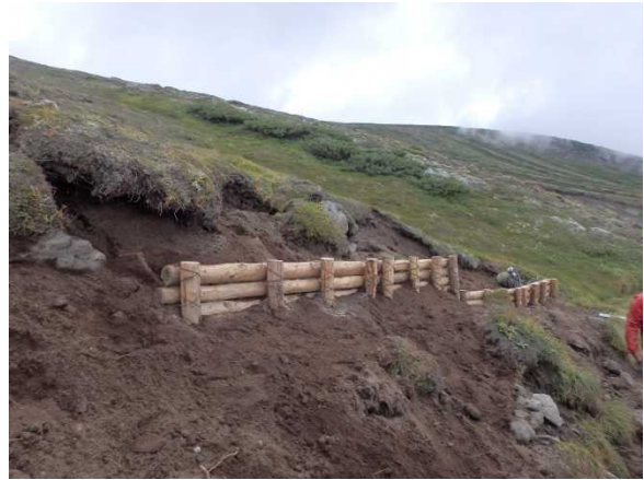
高山帯に設置された木柵土留工は 効果の検証が必要
