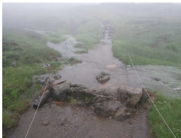
石で堰き止め登山道外に排水する
