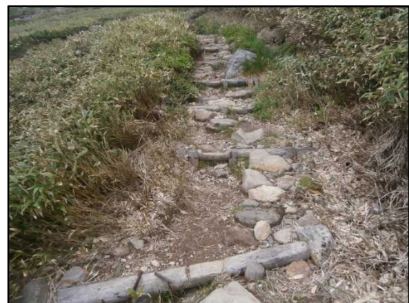
安定した木柵＋石組（水量が少ない区間）
