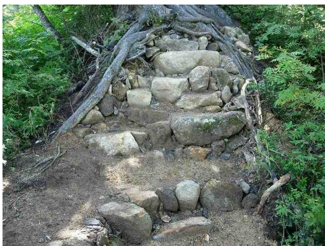
愛山溪 2005. 8月施工
