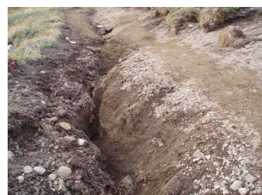
すぐに深く掘れる可能性がある
