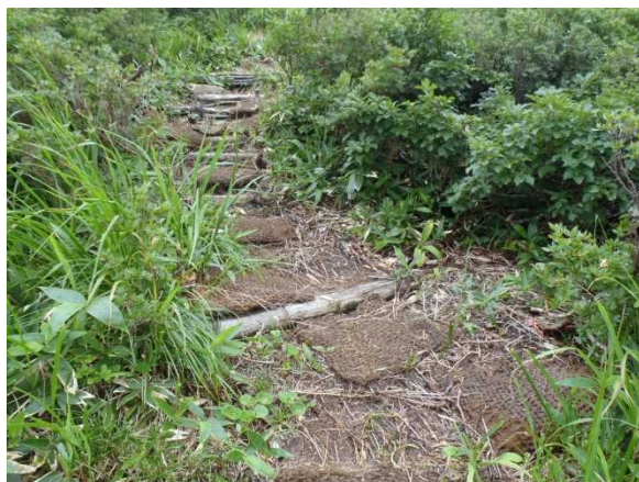
ヤシ土嚢を踏み面に置きぬかるみ化を防ぐ ヤシ土嚢の背後に土砂が溜り歩行部が安定 朝日連峰 以東岳直登コース
