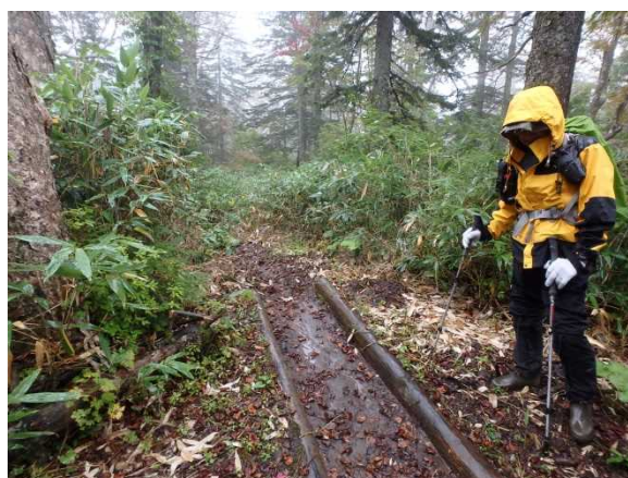
土砂除去を考慮し杭を溝内に打たない 短縮口分岐～カムイ天上間(2014.9.9)
