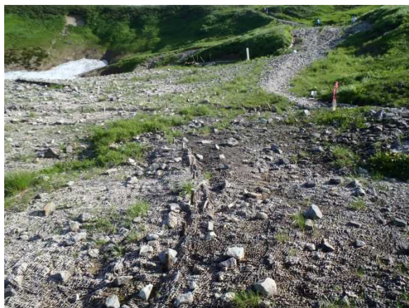
雪田草地の植生基盤として設置
