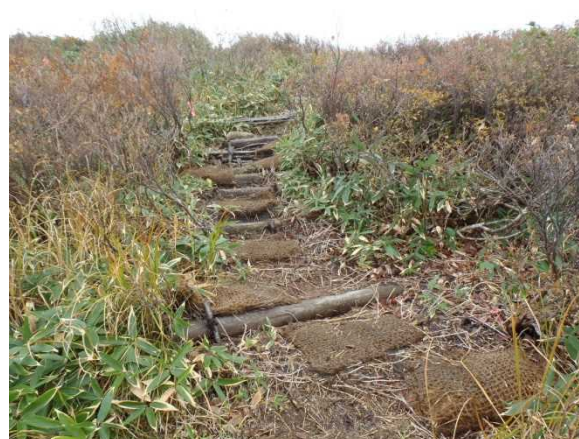
急勾配部には木柵土留を設置
