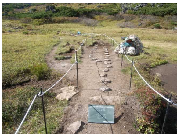
施工時 (2009 年度施工)
