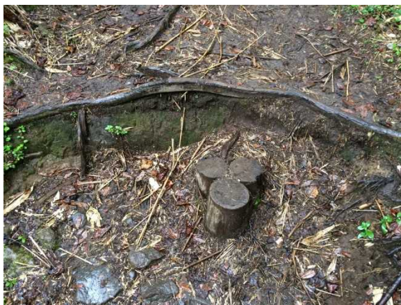
丸太杭で作られたステップ 短縮口分岐～カムイ天上間(2014.9.9)
