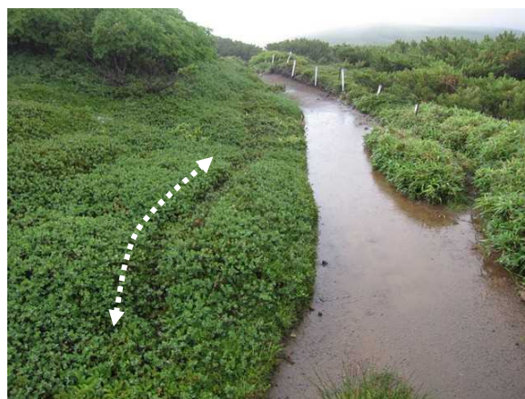
ぬかるみを避け植生上を歩いた痕跡あり 導水処理とともにロープ柵の設置が必要 雲の平 (2015.8) 大雪山グレード3
