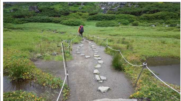
施工5年後 植生が回復
