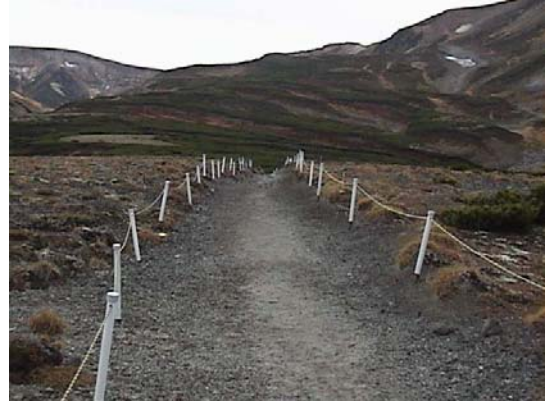
写真 64 立入防止策（高さのちがい、支柱の違い）
