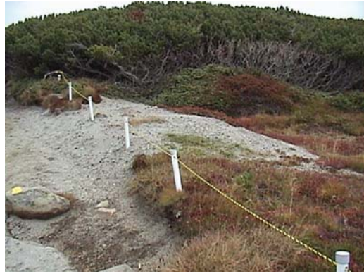
写真 35 土砂が流出する状況（黒岳石室）
