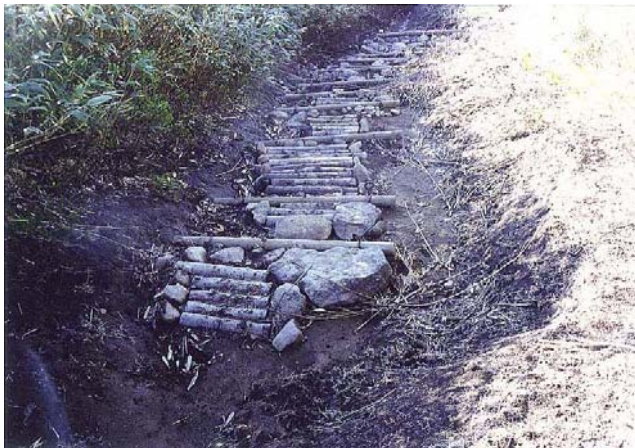
写真 44 愛山溪での丸太による階段処理
