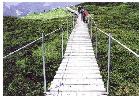
写真 28 大山山頂部の木道 (地面から 1 m 程度高く設置)
