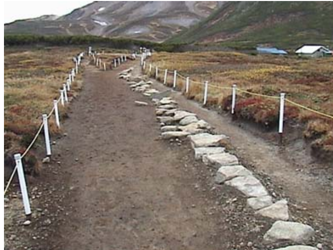
写真 30 飛石のステップ (黒岳石室)
