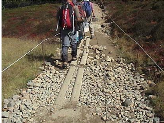
写真 63 立入防止策（高さのちがい、支柱の違い）
