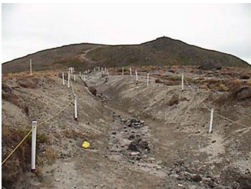
写真32 高山帯における水路化（黒岳石室～北鎮岳）
