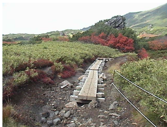
写真 47 木道設置箇所
