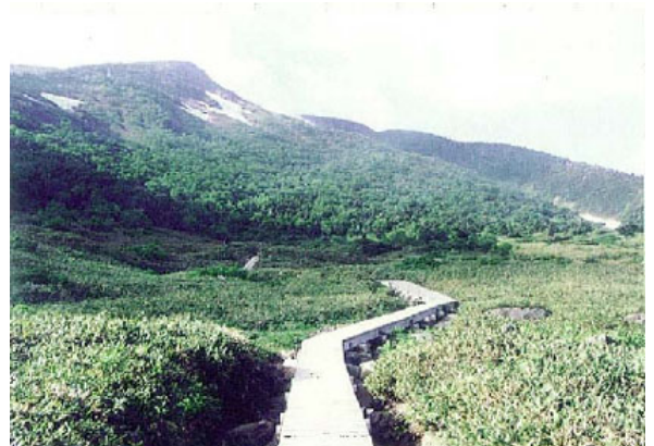
写真 9 南竜が馬場の湿原でガリー化した部分をフトン籠基礎の木道により、土砂の堆積を図っている。
