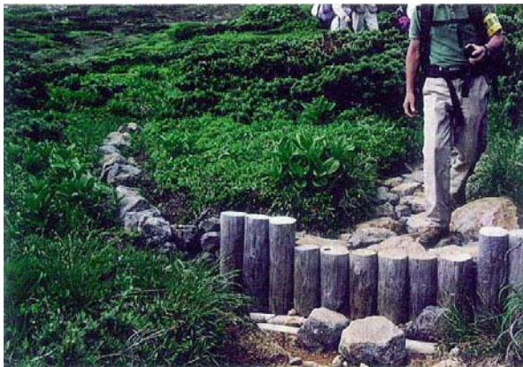
写真 8 水通しの土留め処理と石を用いて水を誘導することを試みている。丸太が飛び出たり根際の浸食が見られる。
