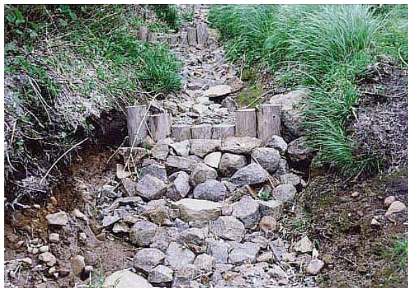
写真 15 同様の対策が急勾配箇所で行われているが、側面部の浸食への対策も必要となる。
