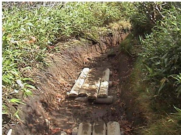
写真 48 トラバース箇所での水路化（裾合平）
