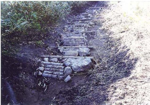
写真 44 愛山溪での丸太による階段処理
