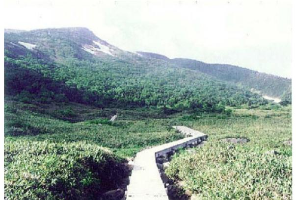
写真 9 南竜が馬場の湿原でガリー化した部分をフトン箆基礎の木道により、土砂の堆積を図っている。
