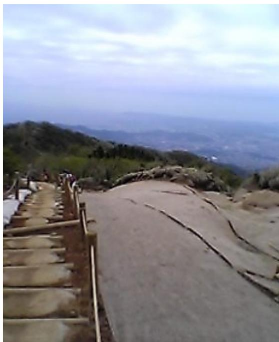
丹沢での植生マットによる植生復元（シュロマットで土壌の移動を防ぐとともに、種子を捕捉して植生回復を図る。）
