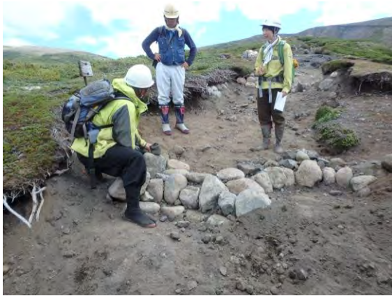
石組による床止め工
