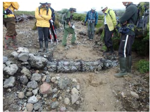
フトン籠による床止め工
