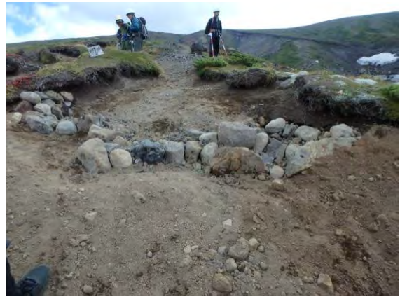
石組による床止め工
