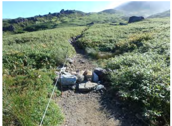
谷筋からの表流水が流入しないよう導流工を設置
