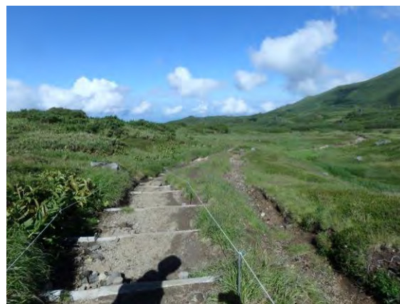
木柵による整備箇所
