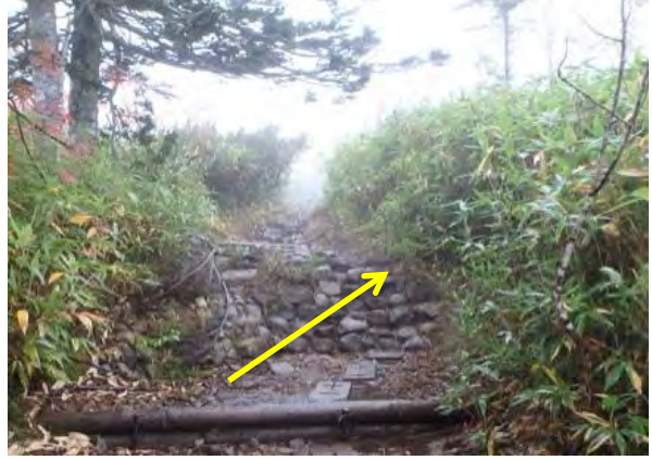
大きな段差箇所を小ぶりの石で石積 横断方向に斜めにステップをつける
