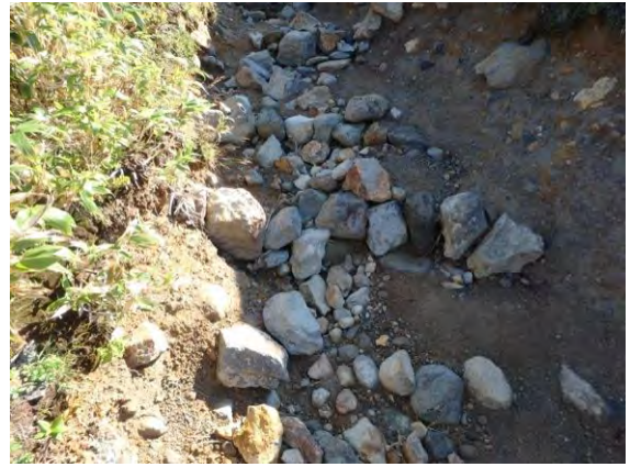
破損・崩壊した石組（石組の下が洗掘）
