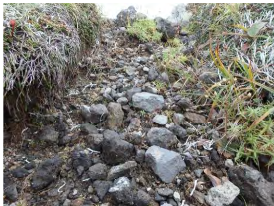
側方の植生はオーバーハング状態
