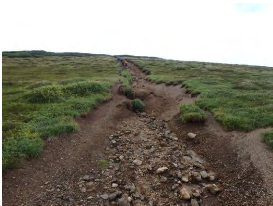
侵食箇所下部区間の状況(やや進行)
