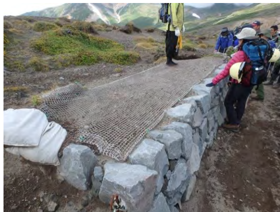
緑化ネットが腐食している
