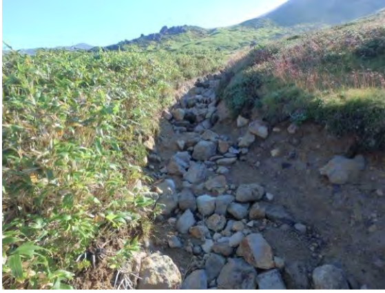
破損・崩壊した石組（石組の下が洗掘）
