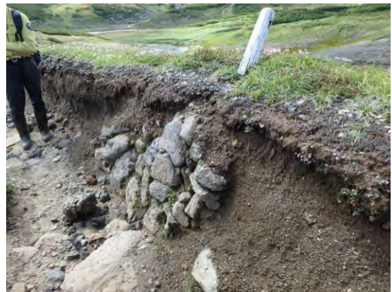
新道侵食部側面の修復箇所
