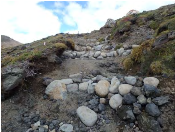
上部区間は石組を連続設置
