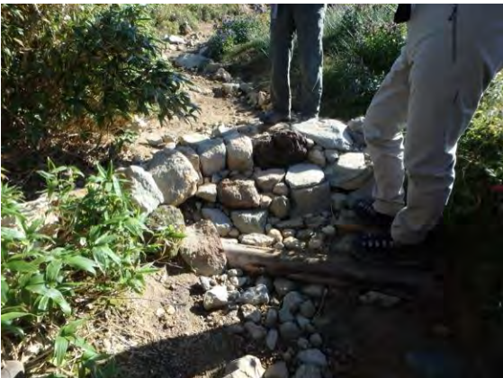
谷筋からの表流水が流入しないよう導流工を設置
