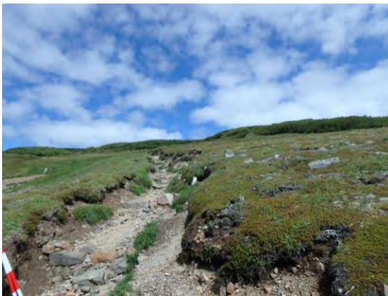
新道の荒廃状況
