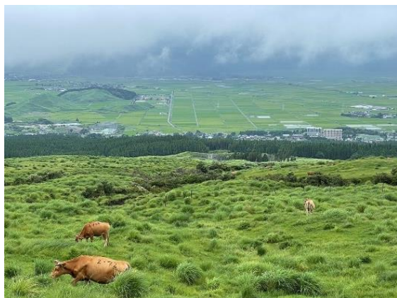
草原内で景観に配慮された堰堤の例
