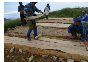
【2班：根巻ロール等の敷設】
