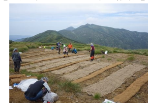
【3班：砂防ダムを作成】
