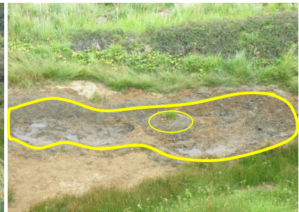
【作業後約 3 時間で水が滲出した】
