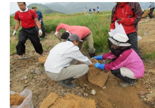
【5班：ヤシ土嚢の設置】
