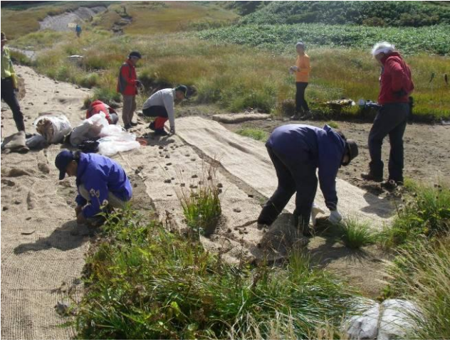
番線を加工したピンで緑化ネットを固定します
