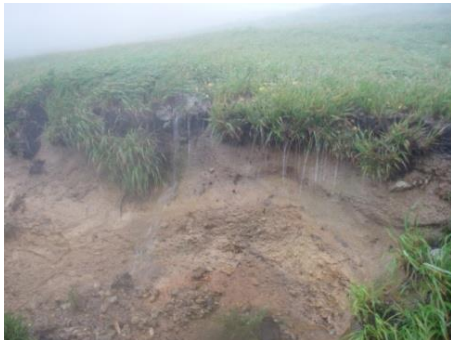
周辺の植生帯から侵食された登山道に表流水が流れ込む状況
