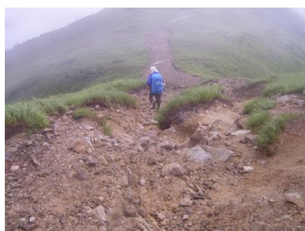
拡幅・侵食された登山道
