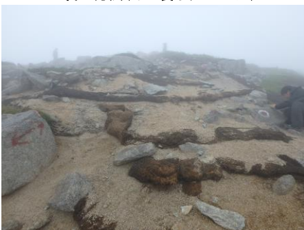
土留の方法(ヤシ製ネットロール)
