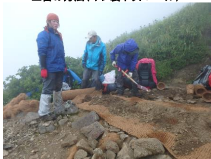
土留の方法(ヤシ製ネットロール)
