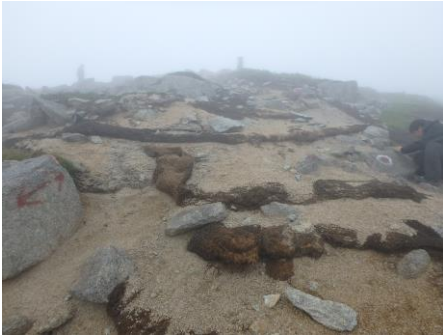
土留の方法(ヤシ製ネットロール)
