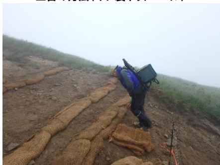
土留の方法(ヤシ製ネットロール)
