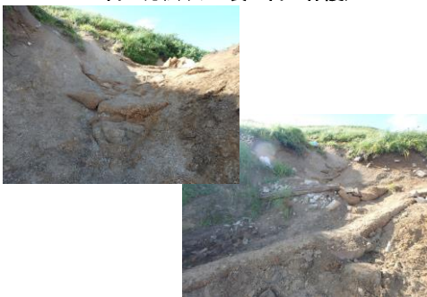
土留の方法(ヤシ製土留の保護)
