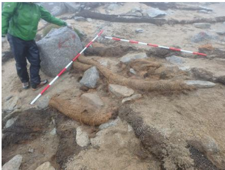
土留の方法(ヤシ製ネットロール改良型)
