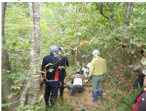
【倒木を利用して、排水対策作業中】
