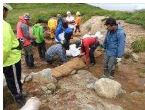
【ダムを造っているところ】
