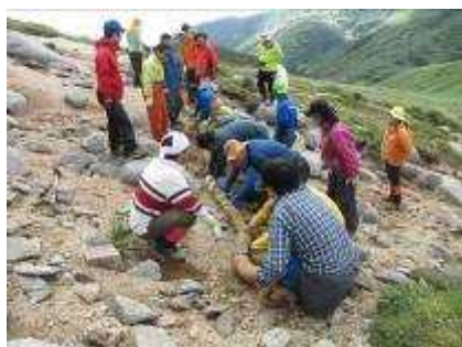
【15mのヤシ製緑化ネットを皆で巻いている】
