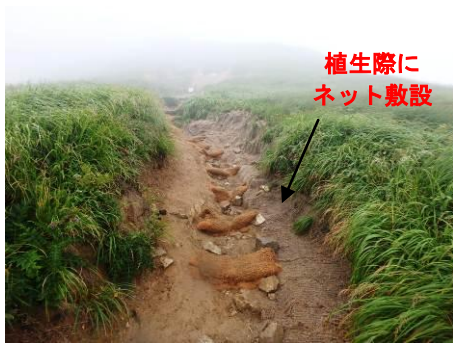
【A班 ヤシ製土のうの土留】
