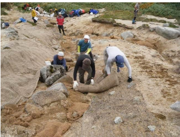
緑化ネット敷設
