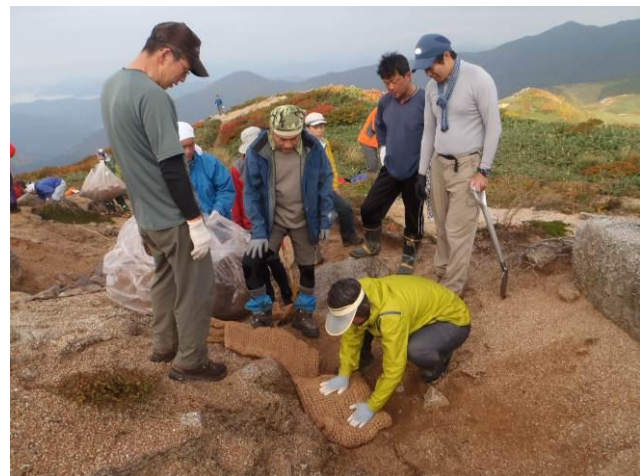
ヤシ製土嚢袋を設置
