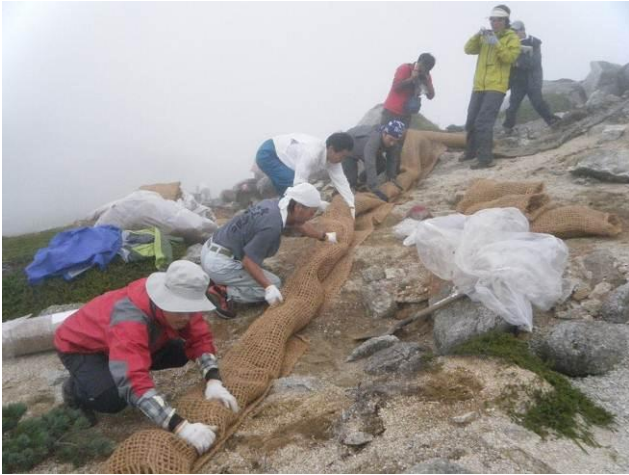
ヤシ製緑化ネットによる土留工
