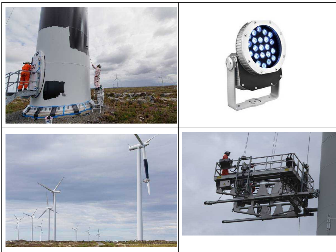
図 3-4-6 Jannicke Nilsen 氏の記事に掲載された塗装作業(上左)と UV 照明 (上右)、ブレードを塗装した風車 (下左) と塗装作業 (下右) 上段 : http://www.tu.no/kraft/2014/02/25/kan-uv-lys-brukes-som-usynlig-fuglegjerde-rundt-vindparker より転載、下段 : http://www.tu.no/kraft/2013/09/18/prisen-for-a-male-atte-vindturbiner-750.000-kroner#cxrecs_s より転載
