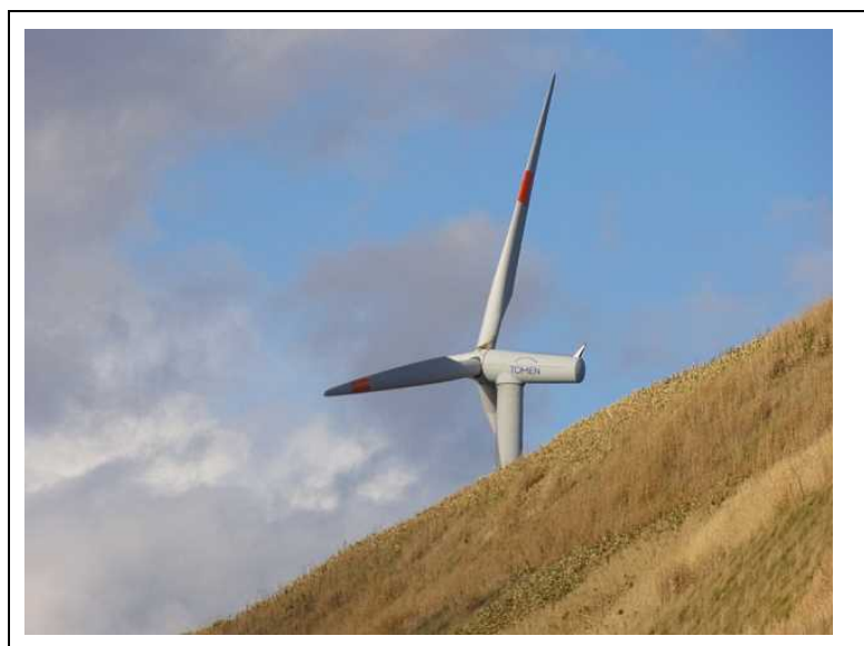
図 3-4- 5 ブレード塗装された風力発電施設
