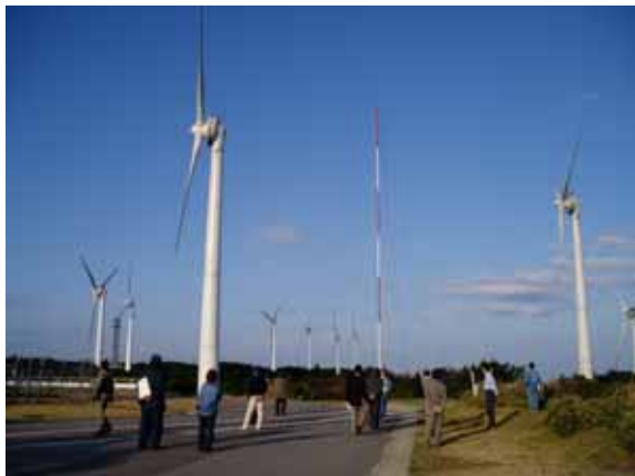
変電所より展望
