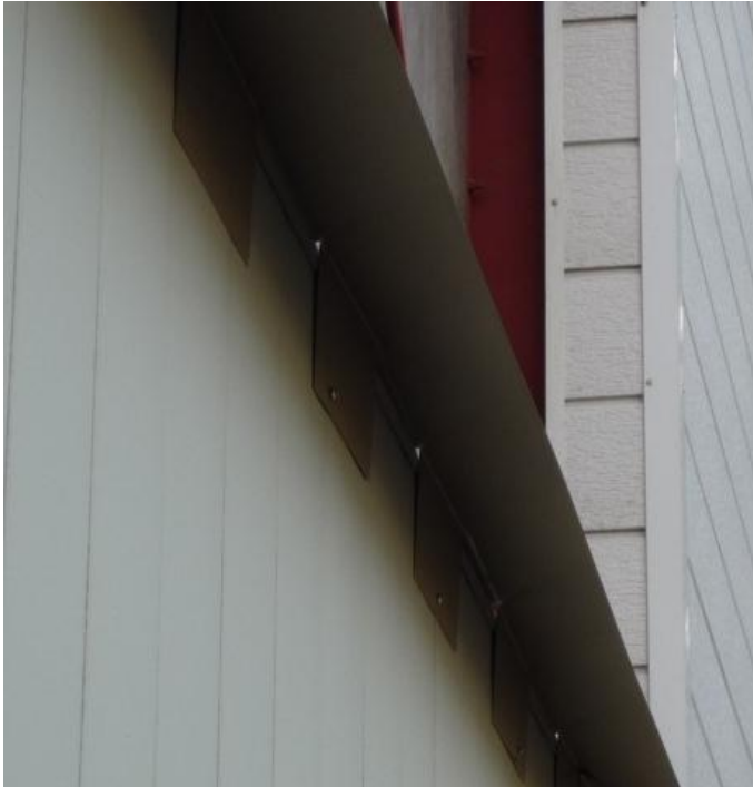
建物へのテン返し設置状況
