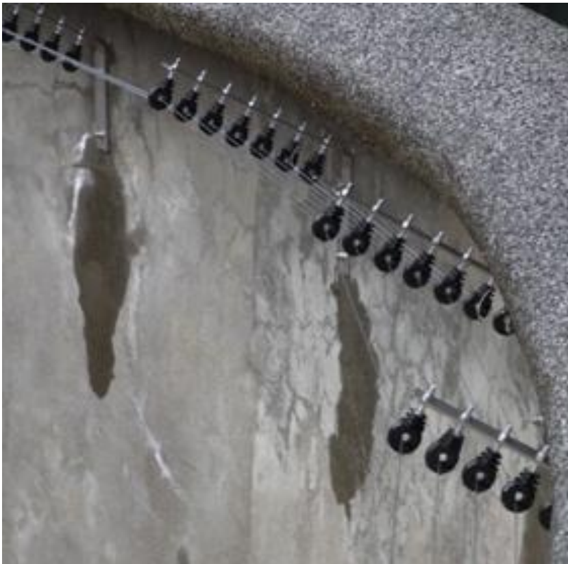
上野動物園での電気柵 (7線)設置状況
