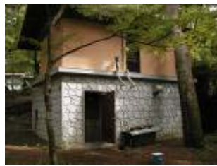
地下処理室入口
