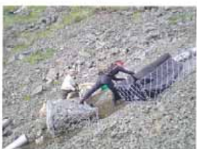
ふとん庵に防水シートを敷く
