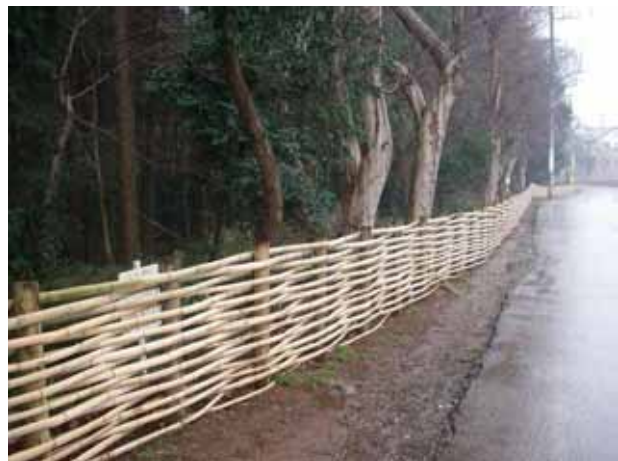
伐採した竹により作成したフェンス
