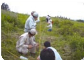
植生帯と防護柵の設置状況
