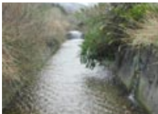
湿原内のコンクリート三面張り水路
