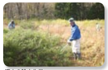
灌木の除去作業
