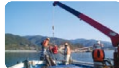
小型クレーンと排砂ポンプ
