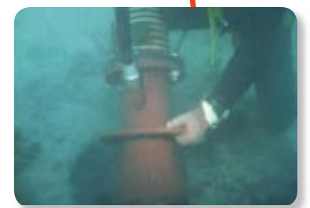
泥土除去状況（吸引）
