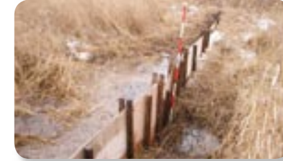
落合沼流出部堰上げ直後の状況（堰の延長は10.5m、水路底から約1.1m堰上げ）
