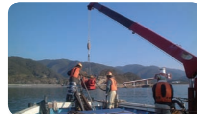
小型クレーンと排砂ポンプ
