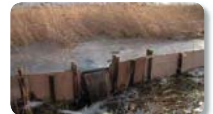
堰上げ2日後の状況（融雪等の影響で相当量の越流が生じている）
