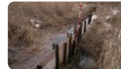
落合沼流出部堰上げ直後の状況（堰の延長は10.5m、水路底から約1.1m堰上げ）
