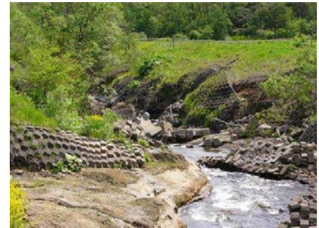
川底が削られた河川 (拡幅による流速低下策や河床安定のための の工作物を設置中)
