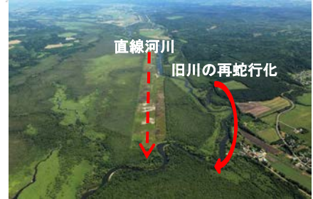
旧川復元による直線河川の再蛇行化を実施
