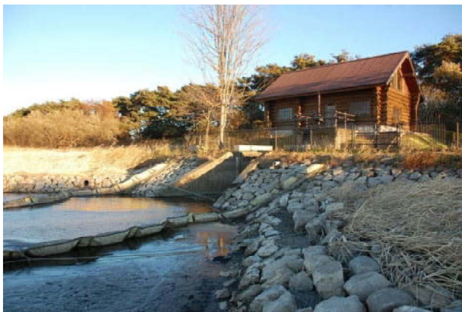
(多々良沼からの導水のための揚水機場)
