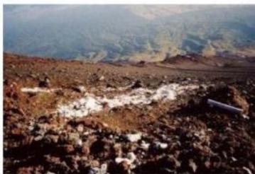
\* 富士山では8月末～9月上旬に便槽の蓋を開き、貯まった尿を放流する。地質が浸透性の大きいスコリア層のため、固型分は地表に残り、水分は地下浸透する。
