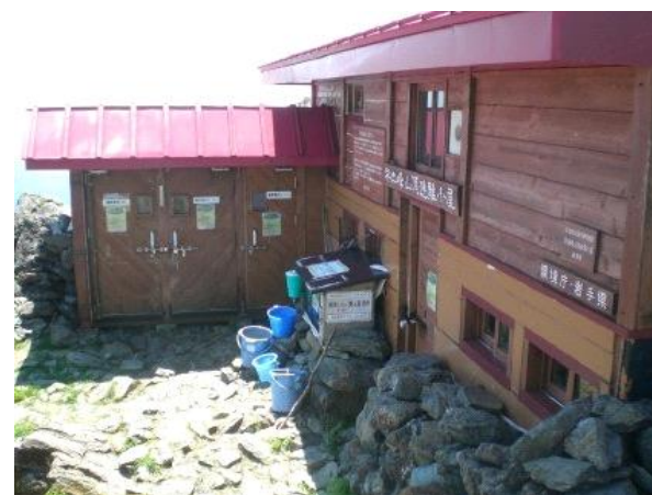
②山頂避難小屋(トイレブース、無人販売箱)
