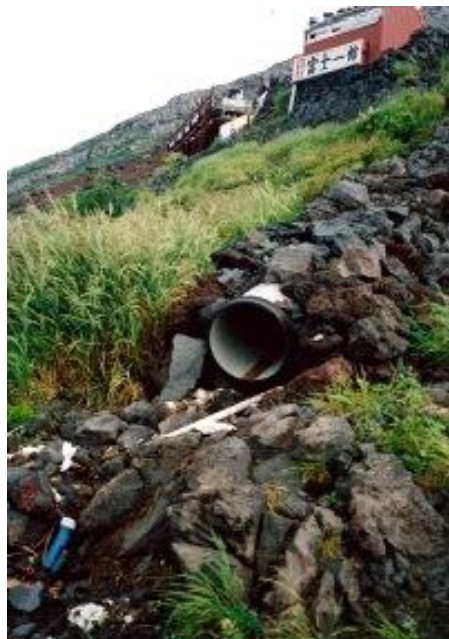
④富士館の排水口(平成14年8月13日)
