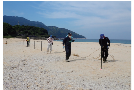
保護柵を設置している様子
