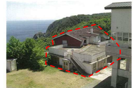
リアス式海岸の絶景への眺望を阻害している廃屋(R1年度撤去事業)
