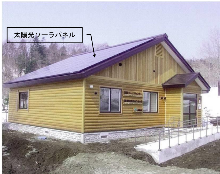
管理棟の屋根に太陽光ソーラパネルを設置している
